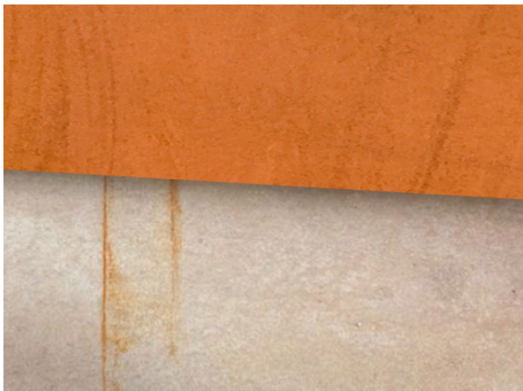
Macchie di ruggine sul pavimento derivanti dalla dilavazione delle pareti di fioriere in corten non protette
