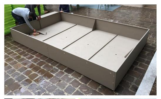
Giardini pensili con grandi vasche di contenimento senza limite dimensionale e altezza vengono realizzate grazie a una progettazione dei componenti modulari il cui montaggio viene eseguito sul posto.
