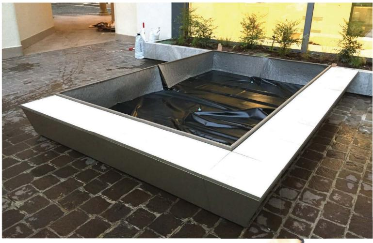
Le vasche, di qualsiasi dimensione e forma, hanno comunque il fondo in PVC in appoggio sul fondo in acciaio; lo scarico di troppo pieno garantisce il rilascio dell'acqua in eccesso, quindi l'acqua di irrigazione che scende al fondo ha sufficiente tempo per essere assorbita dall'argilla espansa e per capillarità essere ceduta agli strati superiori di terriccio.
